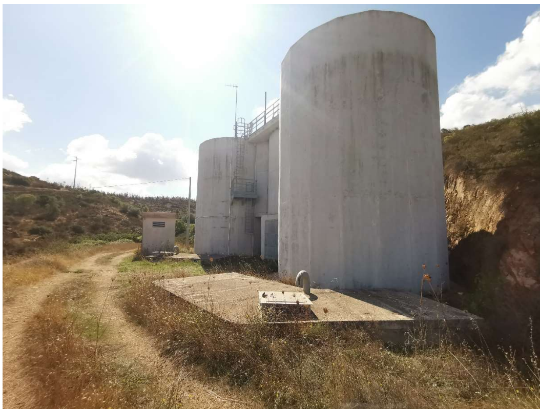
Figura 1: Torri piezometriche dell'acquedotto
